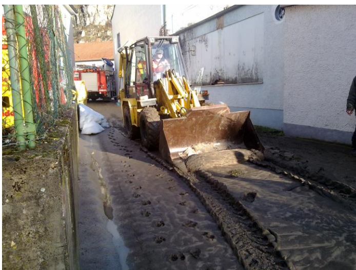
Aufräumarbeiten nach dem Hochwasser
