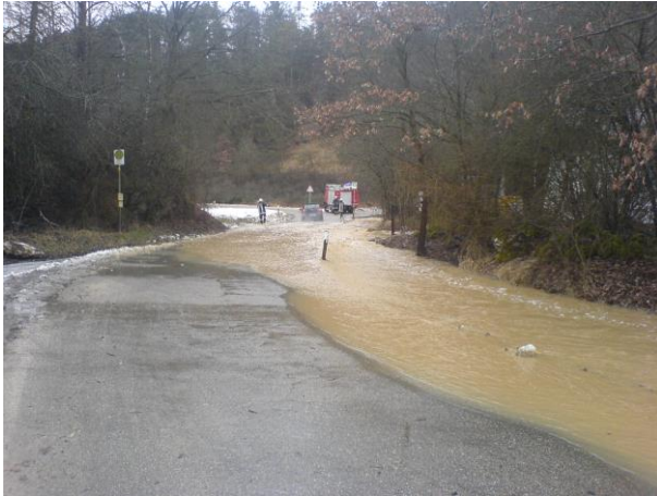
Unwettereinsatz bei der Münchsmühle, aufgrund der starken Schneeschmelze wurde die Straße und das angrenzende Sägewerk überschwemmt.
