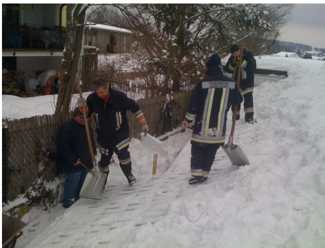
Schnee und Eisbruch in Waldetzbenberg. Bild unten: abtragen einer fast 50 cm dicken Schneedecke vom Dach einer Lagerhalle. Dezember 2010 .
