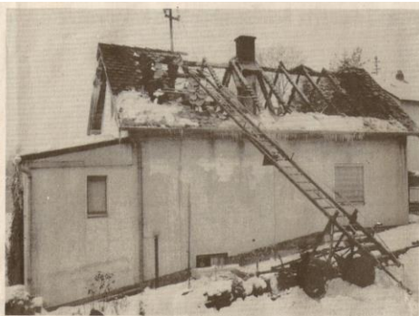
Weitgehend zerstört wurde das Wohnhaus der Familie Zeidler in Laaber, dessen Dachstuhl durch den überhitzten Kamin in Brand geraten war. Sofort einfließendes Löschwasser gab dem Gebäude den Rest.
